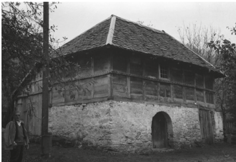
Прилој 21. Магаза на ћелици са двоструком оставом и корпусом на спрату у дрвеном скелету, испуном од талпи, и украсеним појасним укрућењем
