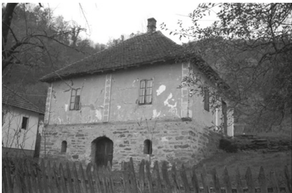
Прилој 9. Четворопросторна кућа на ћелици са вратима и два прозорка отвора на челу ћелице
