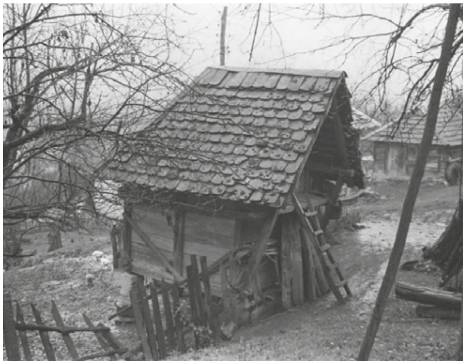
Прилој 25. Амбар на ступце са испуном од талпи
