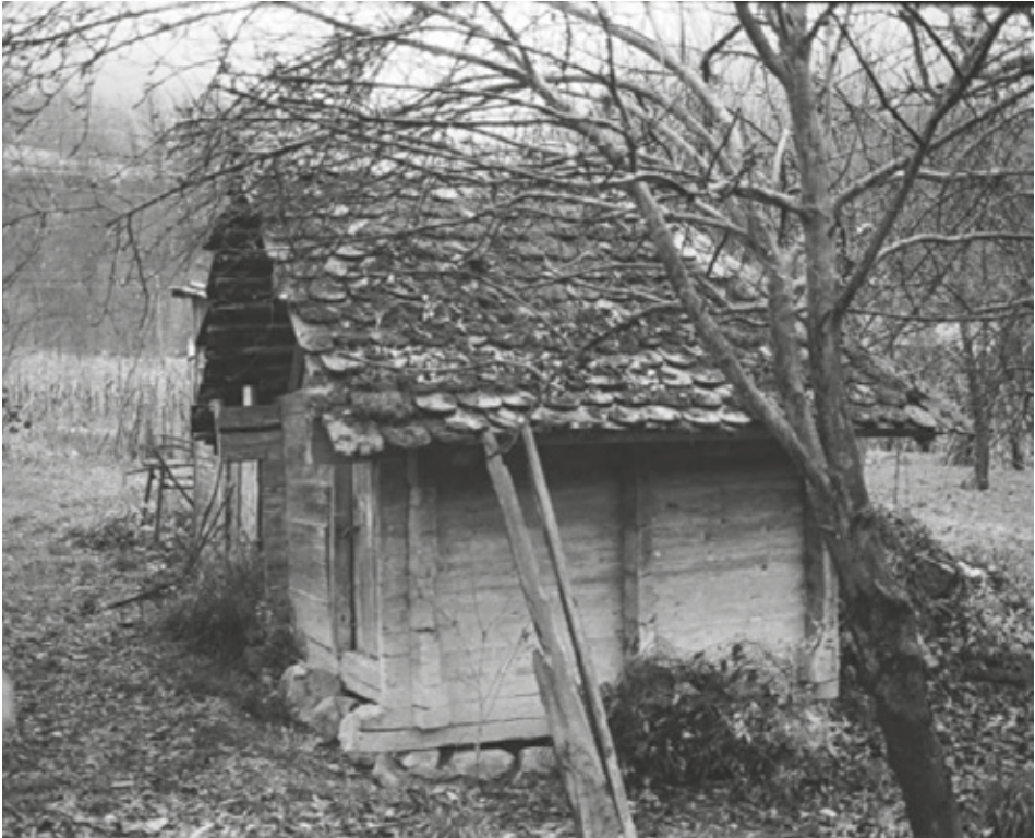
Прилој 26. Амбар од талпи са везом на углу „на ћерт”
