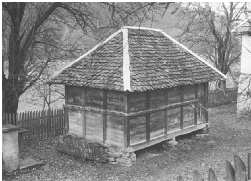
Прилој 17. Магаза са корпусом у скелету и испуном од брвана, ојачањем по средини висине корпуса ослоњена на темеље самце од тесаног камена
