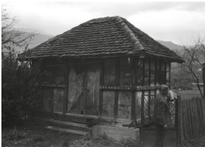
Прилој 18. Магаза у дрвеном скелету, испуном од брвана, четвороводним кровом на темељима од тесаног камена (делом замењен бетоном)
